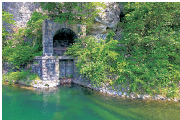
那須野が原の灌漑を目的に、国営事業として造られた那須疏水旧取水施設
