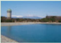
赤田調整池は、那須疏水流域の第3分水、第4分水の用水補給の安定化及び、降雨時の洪水調整を行うために、1980年(昭和55年)造成された人工の池です。有効水量120万 m<sup>3</sup>、満水時面積13.8haになります。また、1年を通じて色々な野鳥が飛来し、カモやサギのほか、白鳥も飛来することがあります。施設の見学ができますので、希望される方は水土里ネット那須野ヶ原(那須野ヶ原土地改良区連合)まで連絡願います。【問い合わせ】☎0287-36-0632
